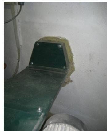
Abb.1: Förderschnecke vom Brennstofflager zum Kessel – z.B. Steinwolle verhindert Übertragung von Vibrationen ins Mauerwerk (Quelle: Stadlober GmbH)
