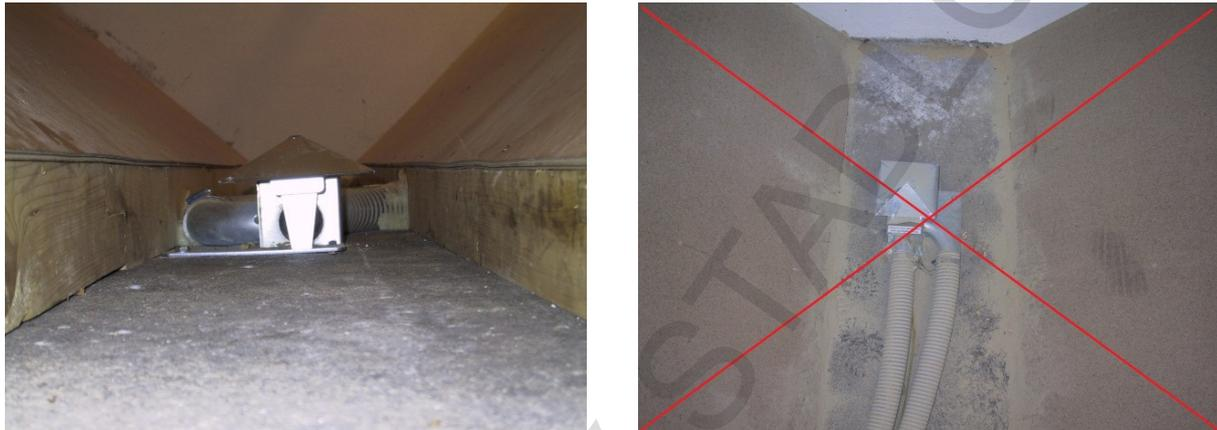
**Abb.8:** Bild links: Sauglanze im Lagerraum mit Saugkanal richtig montiert; Bild rechts: Sauglanze im Lagerraum ohne Saugkanal falsch montiert (Quelle: Stadlober GmbH)
